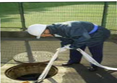
11: MaxCellより防止のため手を添え調整する
