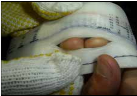
6: 指2本分の切込みをいれ余分なプルテープを切り取る 7: 6の切込みに引き縄(ワイヤー)を結びつける
