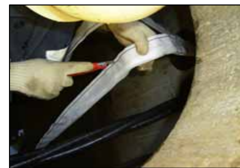
14: Max Cell端部固定のための切り口加工
