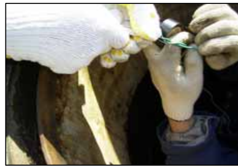
6: 指2本分の切込みをいれ余分なプルテープを切り取る 7: 6の切込みに引き縄(ワイヤー)を結びつける
