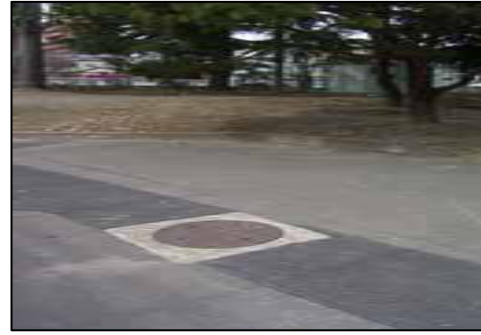
2: 施工場所: ハンドホール
