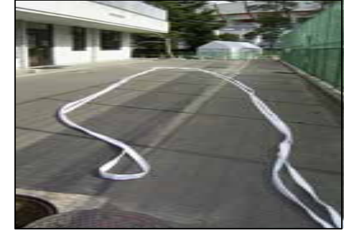
5: 二管路同時引き込み準備
