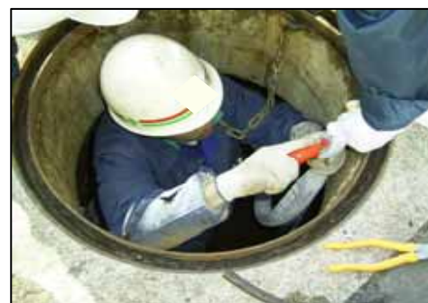
13: インナーダクト余長切断
