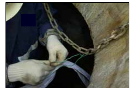
15: Max Cell端部固定
