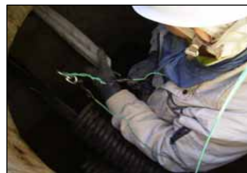
12: Max Cell貫通し約1メートルまで引き出し
