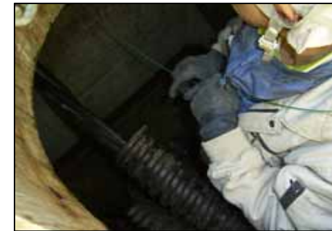
9: パイロットワイヤー引き出し
