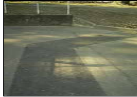
3: 施工場所湾曲部
