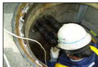
FEP管のパイロットワイヤーにロープを 結ぶ
