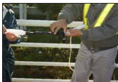
ハーフヒッチでMax Cell端部にビニール テープを巻きつける
