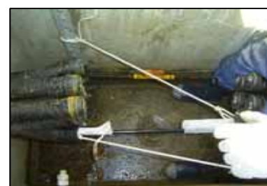
MaxCellが引き込まれないよう マンホールの金具に固定
