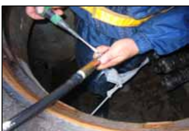
ケーブルのブーリングアイにMaxCellの プルテープを結ぶ
